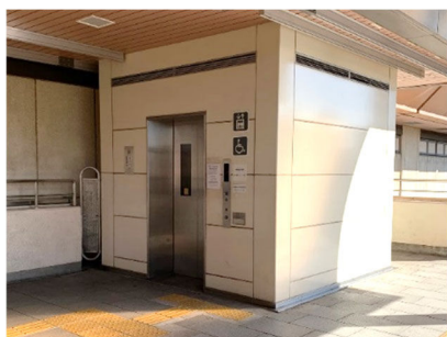
エレベータの整備
