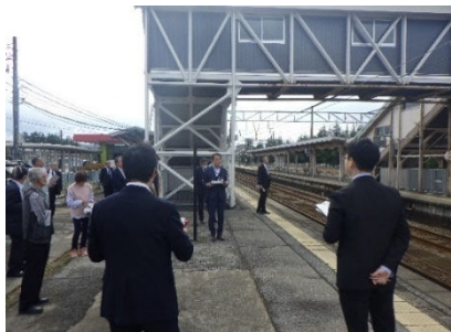
黒部駅駅舎の点検
