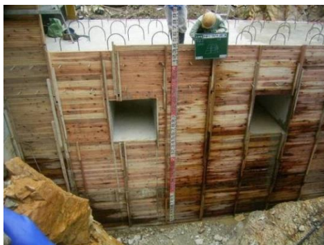
治山工事における木材利用
