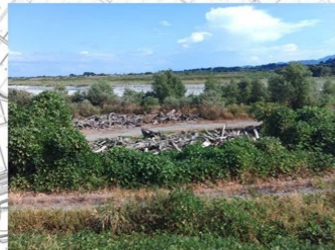
黒部市下立地先（河口から左岸11.2k付近）
