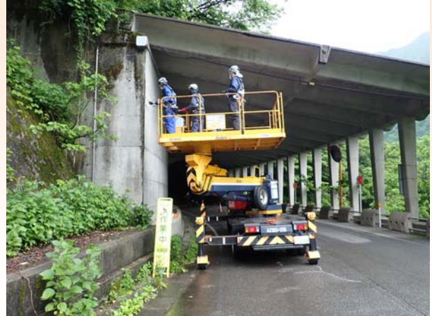
定期点検状況
