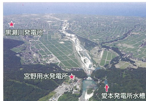
黒部川扇状地 扇の要、愛本堰堤上空より
