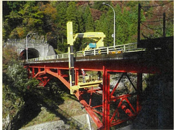
定期点検状況
