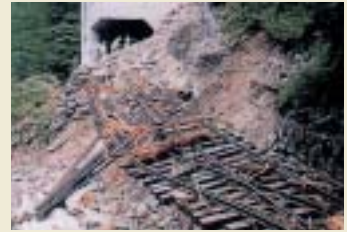
平成7年7月 黒部峡谷鉄道黒薙川引込み線被災状況
