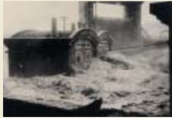
昭和27年7月 愛本えん堤
