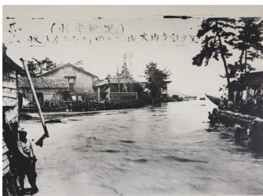
(展示室 昭和9年7月12日の洪水 生地町四十物町方面、大町方面を望む。右奥に中橋があったが流失しました。)
