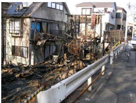
空家等が火元となった類焼事例
