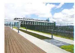
屋上テラス…屋上に無灌水平緑化システムを採用しており、北アルプスの眺望を楽しむことができます。
