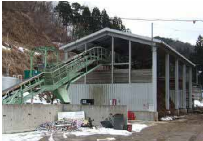
< 写真 > 木材リサイクルセンター
